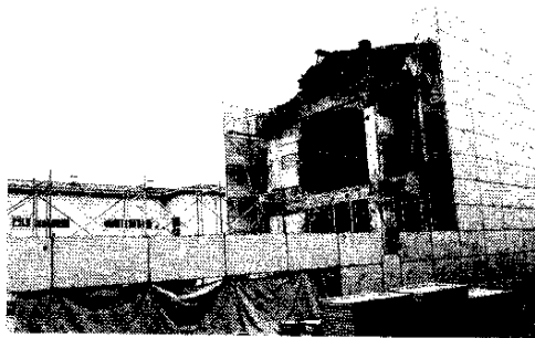
解体作業中の旧校舎
